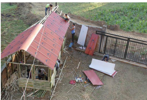
Bauphase im Juni 2019
