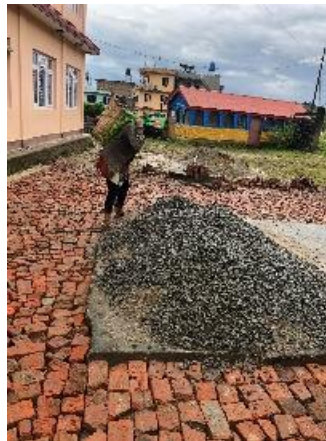
Die Bauarbeiten beännen
